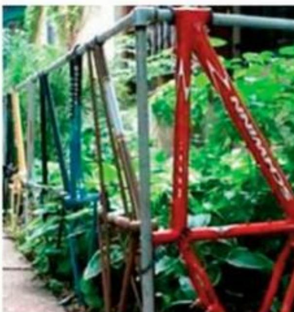
Планируя возвести забор без затрат, бросовый материал собирал на местной свалке. Вкопал по периметру участка трубы-стойки небольшого диаметра. Сверху соединил их через сантехнические переходники перекладинами, надев при этом старые вело- сипедные рамы. Получилось дёшево и сердито.
