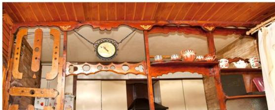
**1.** Закрепил к потолку резной карниз, выпиленный из доски толщиной 15 мм. Установил поперечные вертикальные балки от него до пола, фиксируя их саморезами и гвоздями.
