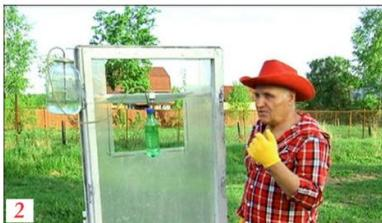
В крышке ПЭТ-бутылки вырезал отверстие по диаметру шланга. Один конец патрубка нанизал на металлическую трубочку, а второй через крышки опустил до упора в пластиковую емкость. Система автопроветривания готова!
