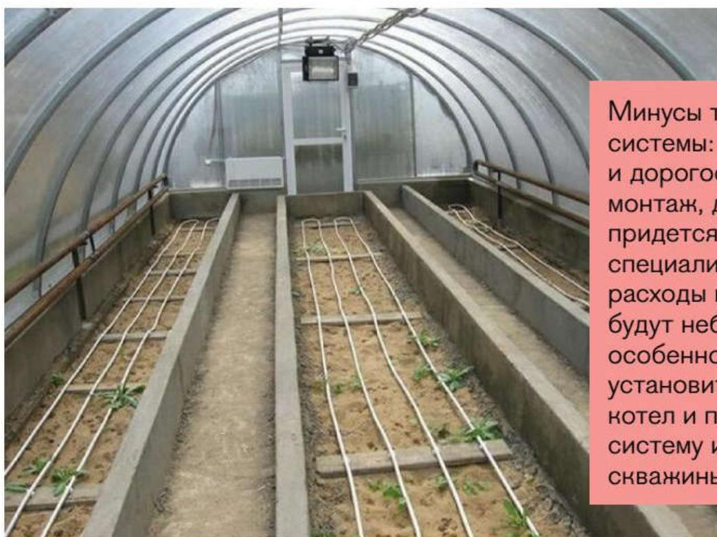
Минусы такой системы: сложный и дорогостоящий монтаж, для которого придется привлекать специалистов. Но зато расходы на обогрев будут небольшими, особенно если установить газовый котел и подавать воду в систему из собственной скважины.
