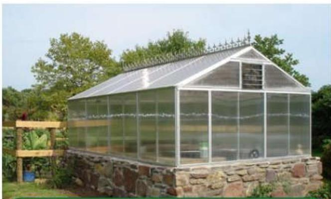
Стенки двускатной теплицы обычно делают высотой 1,5 м, а конек крыши располагают на высоте 1,8-2,5 м от земли.
