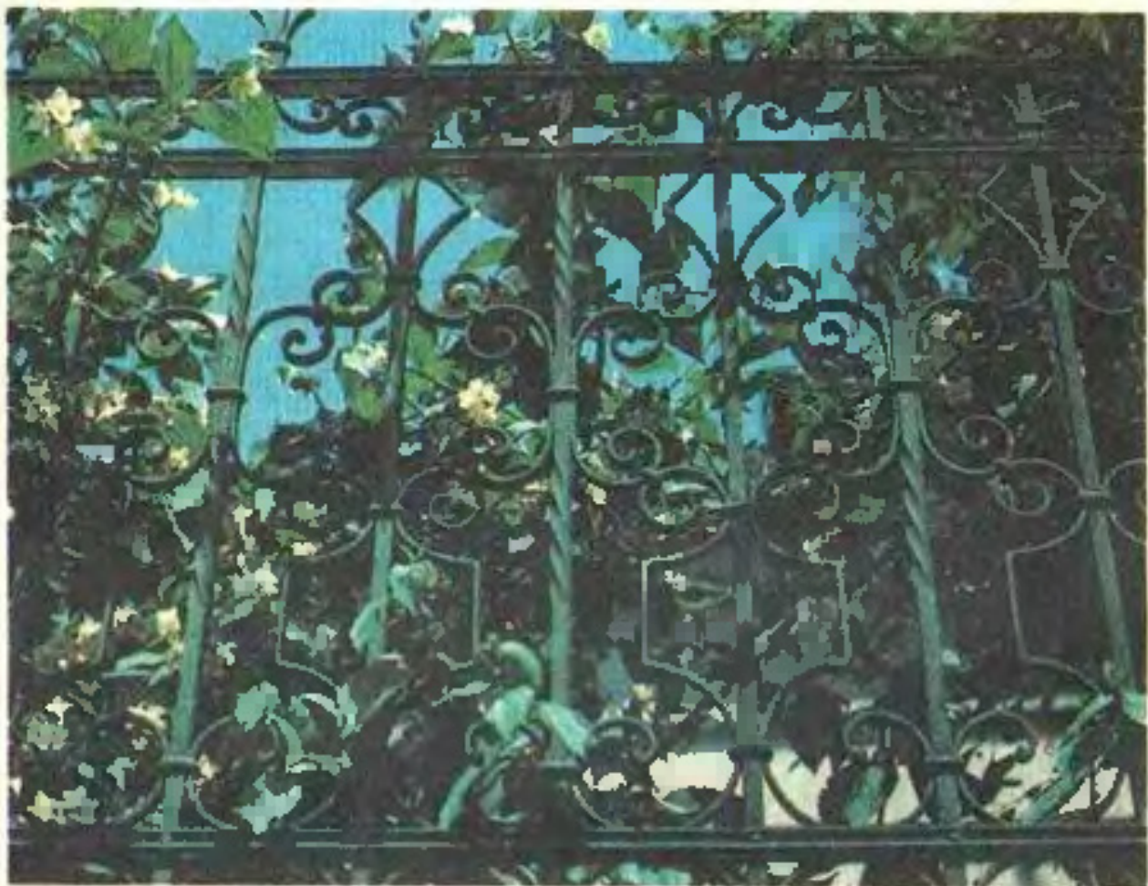
Кованая решетка с креплением элементов хомутами и заклепками
