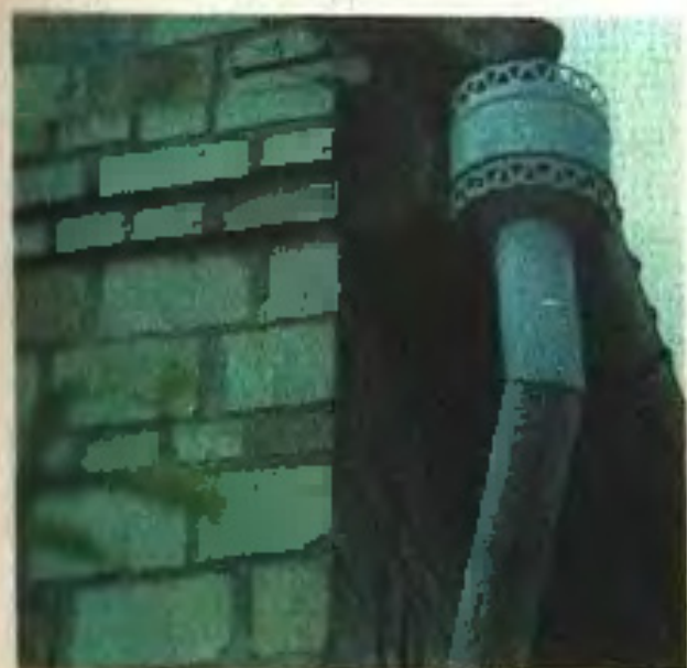
Водослив (просечной металл)
