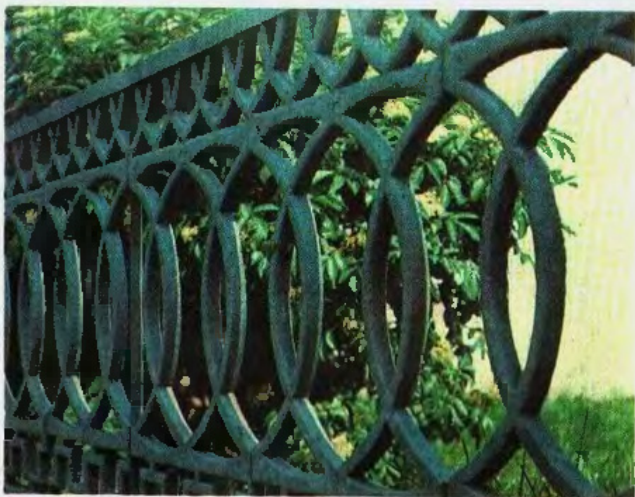
Литые ограждения (фрагмент)
