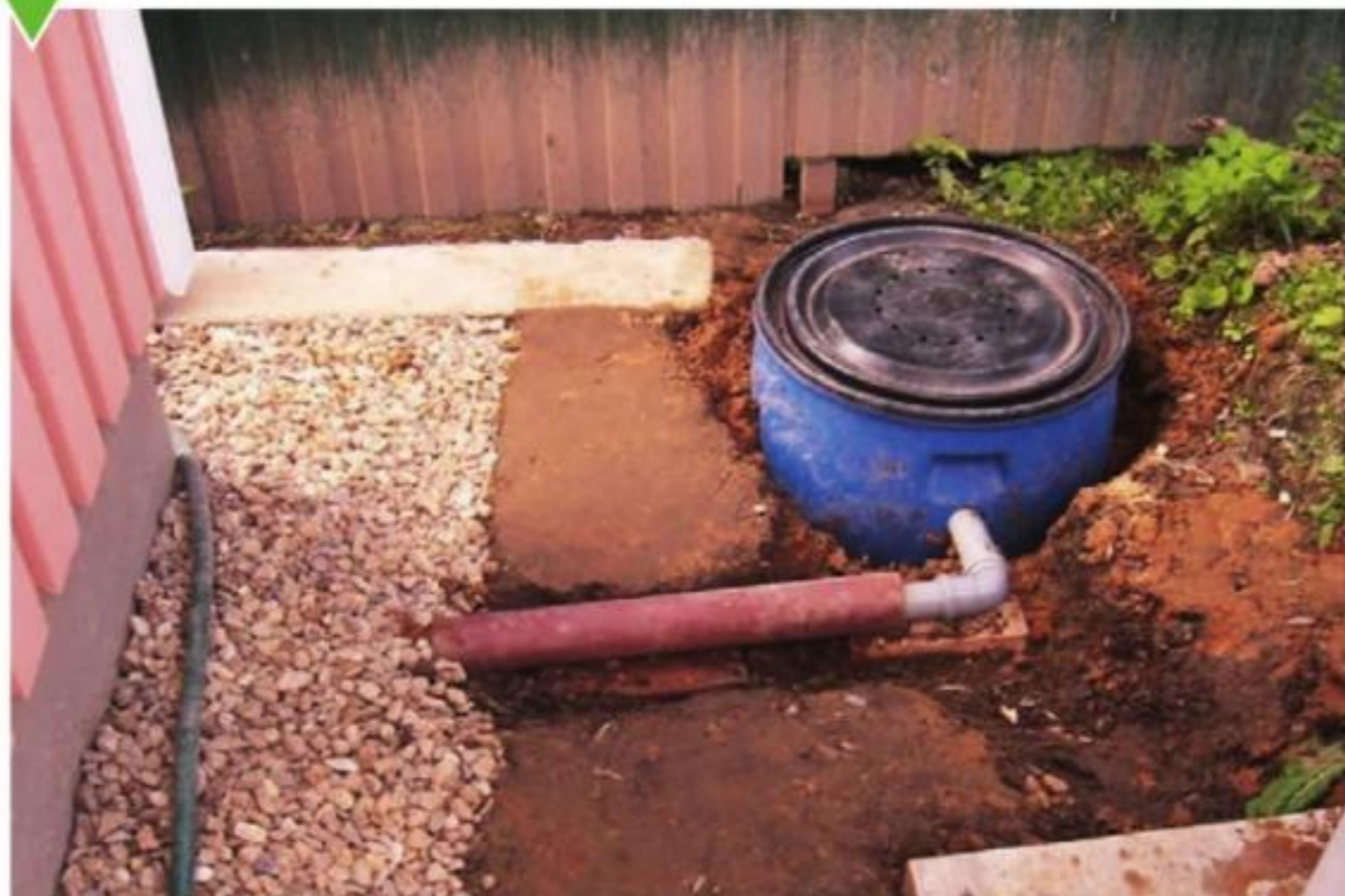
Резервуар из пластиковой бочки
