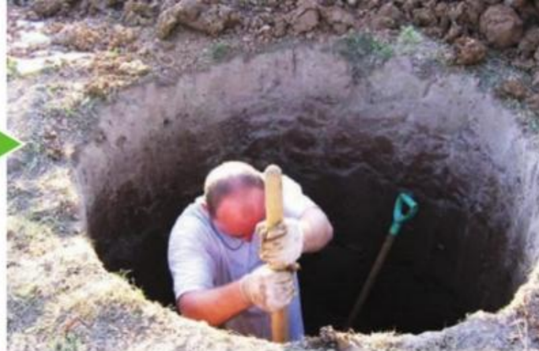
Подготовка выгребной ямы
