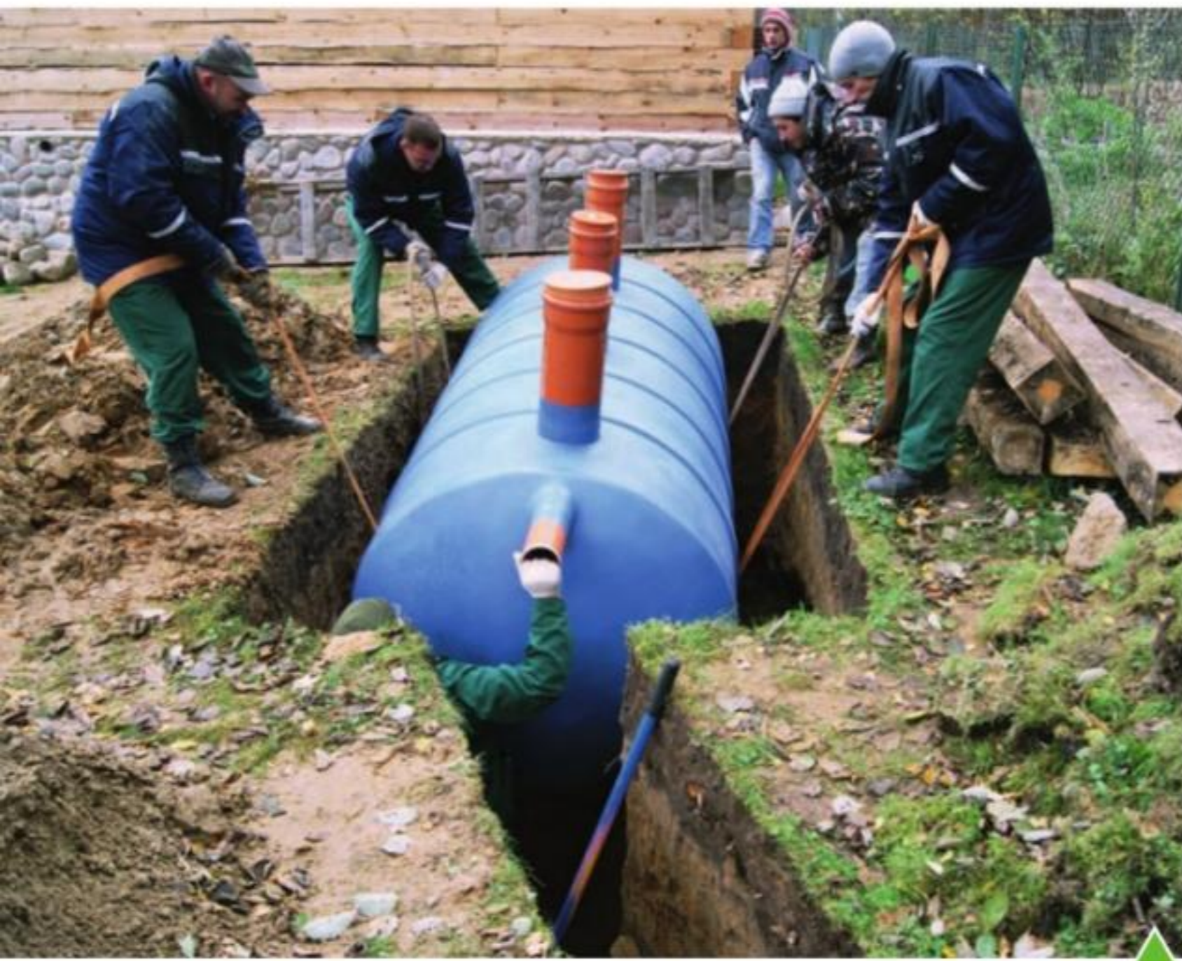
Пластиковый септик аккуратно опускают в яму
